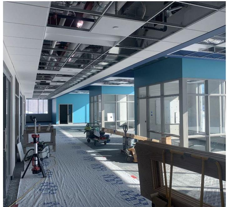
Se instaló la base de la pared y se está instalando la puerta en el área de colaboración del primer piso.
